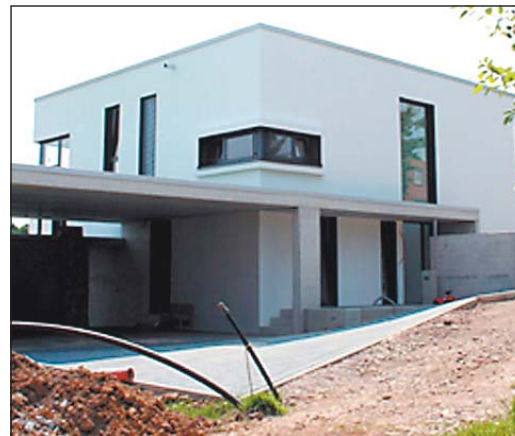
Das Einfamilienhaus an der Berliner Straße hebt sich durch seine konsequente Gestaltung selbstbewusst von der Umgebung ab.
