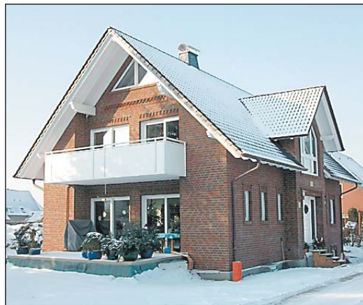
Das Einfamilienhaus an der Otto-Hahn-Straße ist stark gedämmt. Für die Wärmezufuhr sorgt eine Erdsondenbohrung mit Wärmepumpe.
