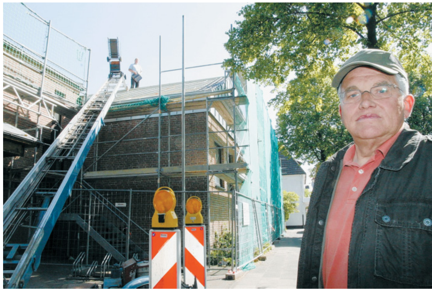
Auf der Baustelle: Helmut Arens vom Kirchenvorstand der St.-Anna-Kirchengemeinde hat einen Blick auf die Sanierungsarbeiten, die an und in dem Gebäude am Kühlmannweg durchgeführt werden. Vom Dach schaut Dachdecker Matthias Mahlke in die Kamera. FOTOS: EBBESMEYER
