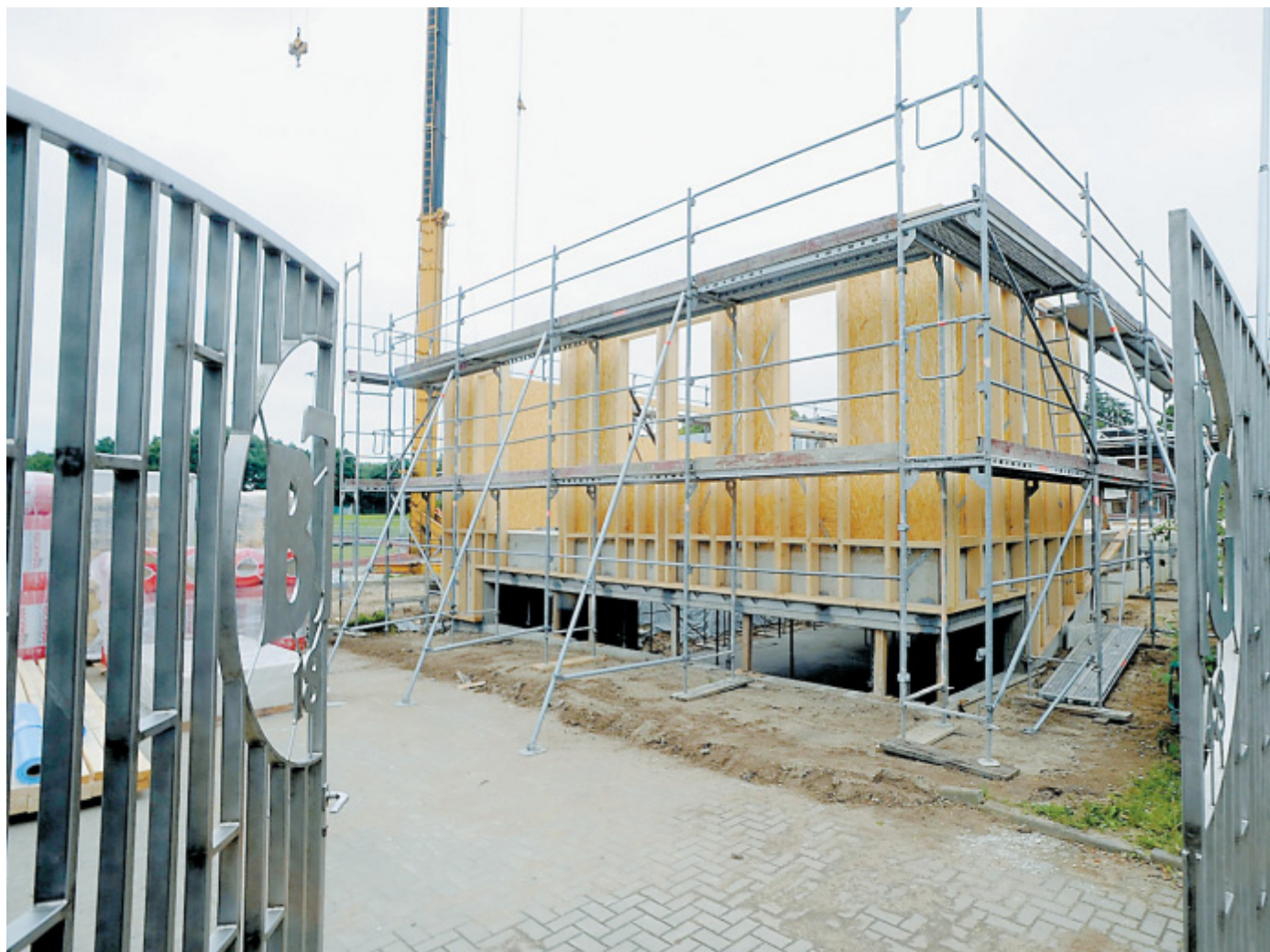
Ein Teil der Holzverschalung steht: Die BTG-Immobilie endet kurz vor dem Tor zum BTG-Kunstrasenplatz. Im unteren Geschoss entsteht Platz für Sportgruppen, oben sind Sozialräume, Sauna und mehr Platz für das Sportstudio eingeplant.
